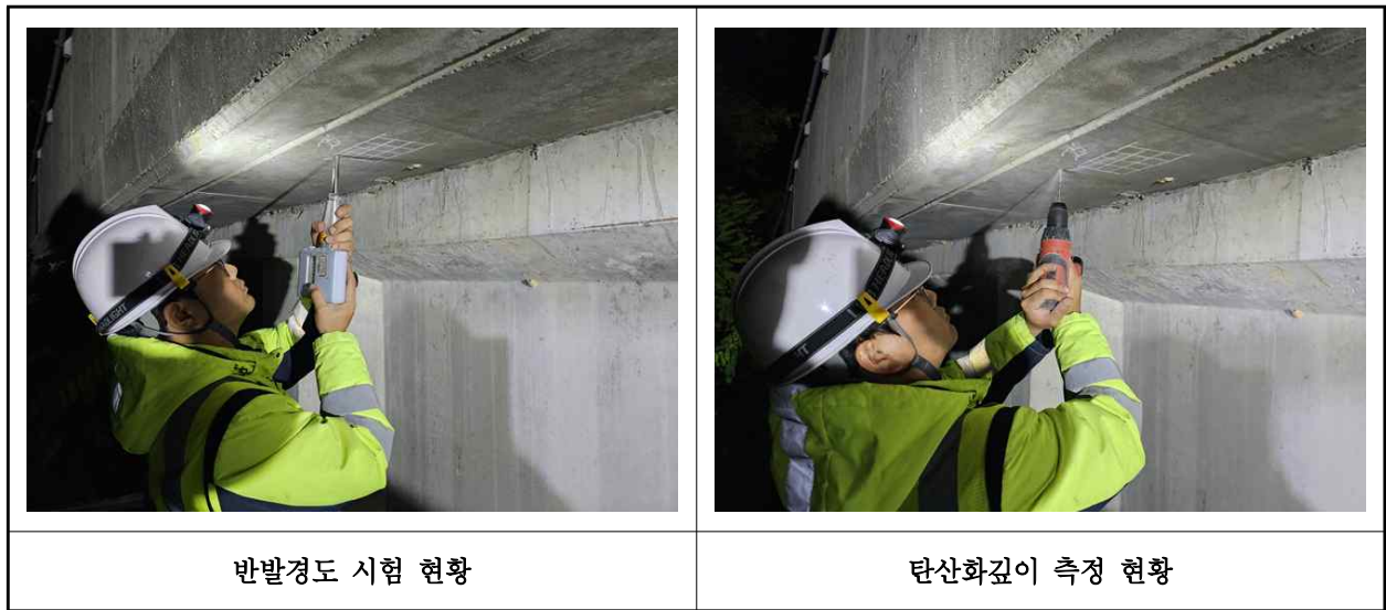
【사진 1.4.1】 콘크리트 내구성조사 현황
