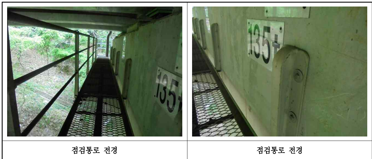
【사진 1.3.25】 교량 점검시설 전경
