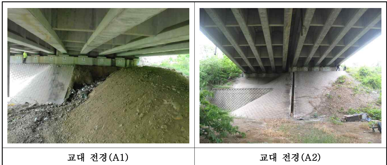
【사진 1.3.8】 교대 전경
