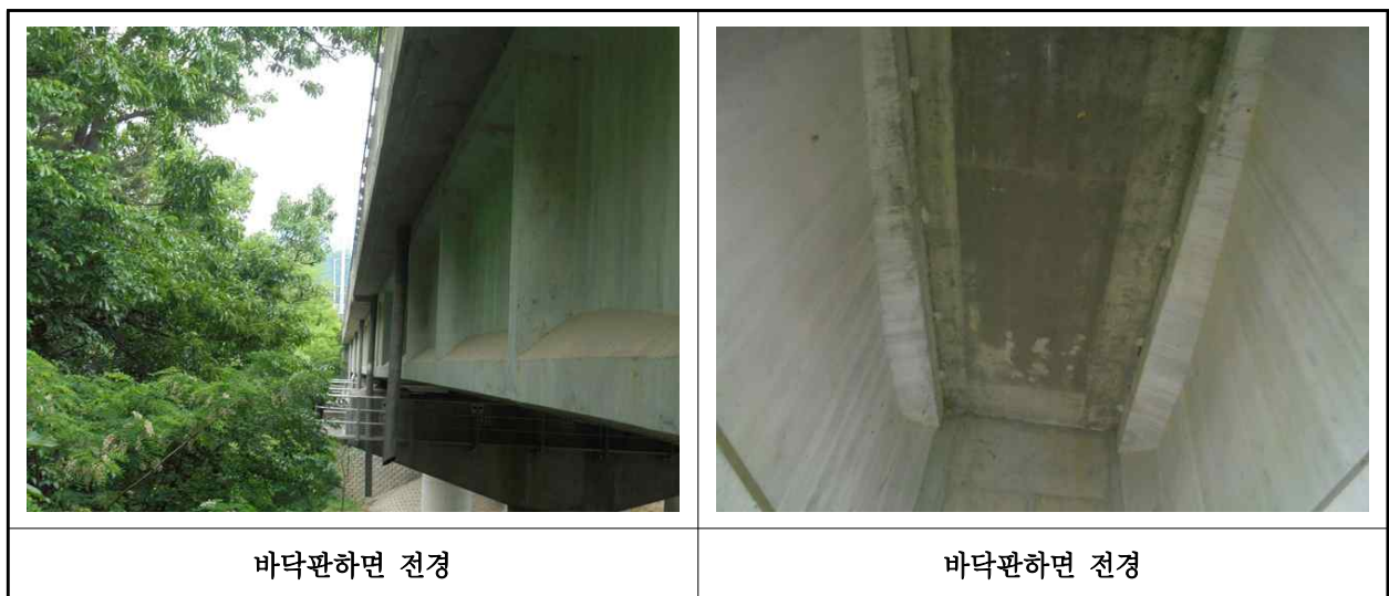
【사진 1.3.2】 바닥판하면 전경
