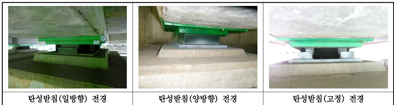
【사진 1.3.12】 교량받침 전경
