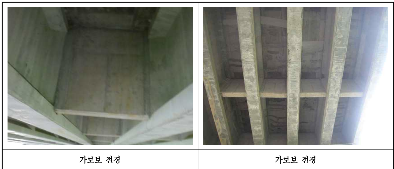
【사진 1.3.6】 가로보 전경
