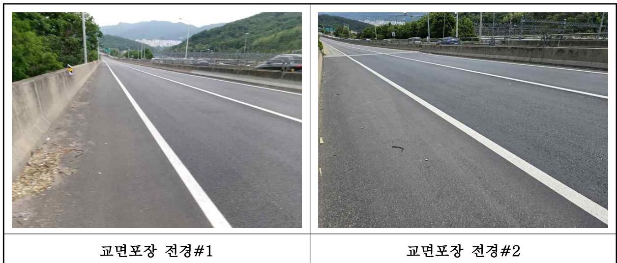
【사진 1.3.19】 교면포장 전경
