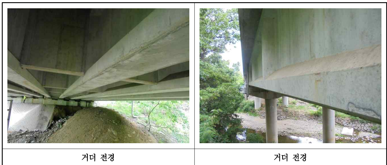
【사진 1.3.4】 거더 전경
