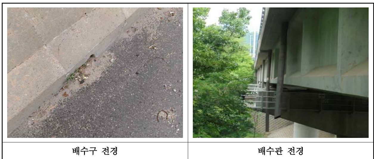
【사진 1.3.21】 배수시설 전경
