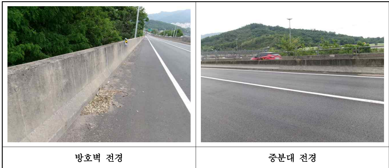
【사진 1.3.23】 방호벽 및 중앙분리대 전경
