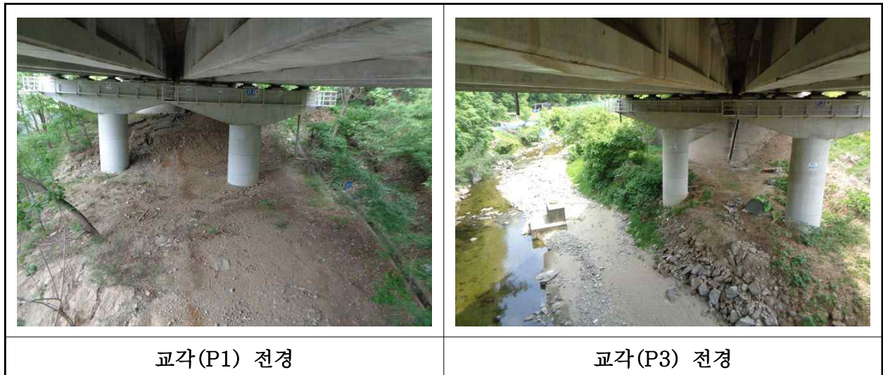
【사진 1.3.10】 교각 전경
